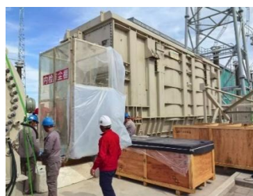
图 3.内检作业现场
